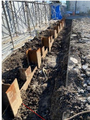
今後、基礎解体や杭撤去のために地盤を掘削することになりますが、掘削に伴う周囲地盤の崩壊や土砂流出を未然に防止するため、仮設の壁を設置する作業を行っています。(山留め工事)
