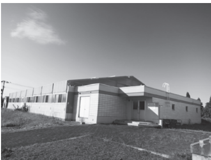
中央小学校のプール
