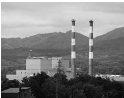
砂川火力発電所
