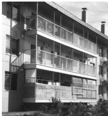
宮川中央団地コンパネ設置状況
