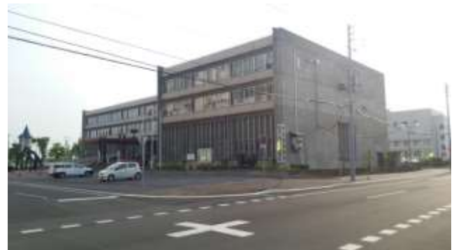
【北東から見た現庁舎】
