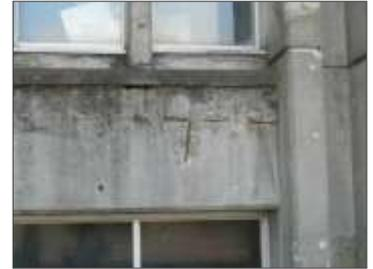
【外壁の鉄筋露出】
