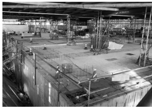
▲現在は新庁舎躯体工事が進んでいます
