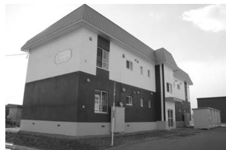
移住定住促進住宅（す・き・すまいる住宅）
