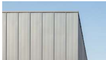
ガルバリウム鋼板の事例の写真
